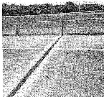
Perfil já instalado
