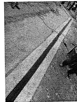
Perfil instalado em ângulo
