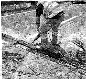
Readequação do berço
