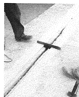
Formatação do berço
