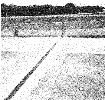
Perfil já instalado
