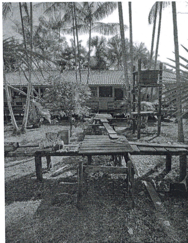
Imagem 04- Detalhe da passarela de acesso a escola .
