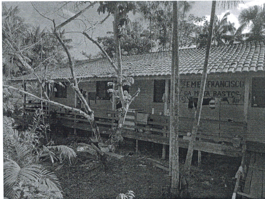
Imagem 06- Detalhe da fachada frontal.
