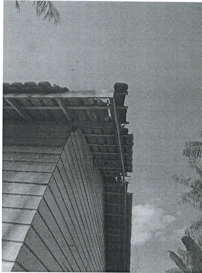
Imagem 21 – Ripas e caibros do telhado deterioradas, telhas caindo.
