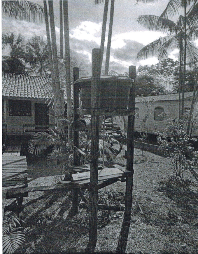
Imagem 05- Detalhes do castelo d'água existente.
