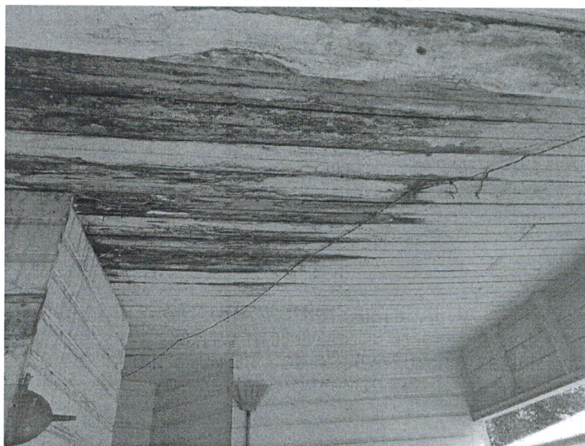
Imagem 09- Detalhe do forro existente.
