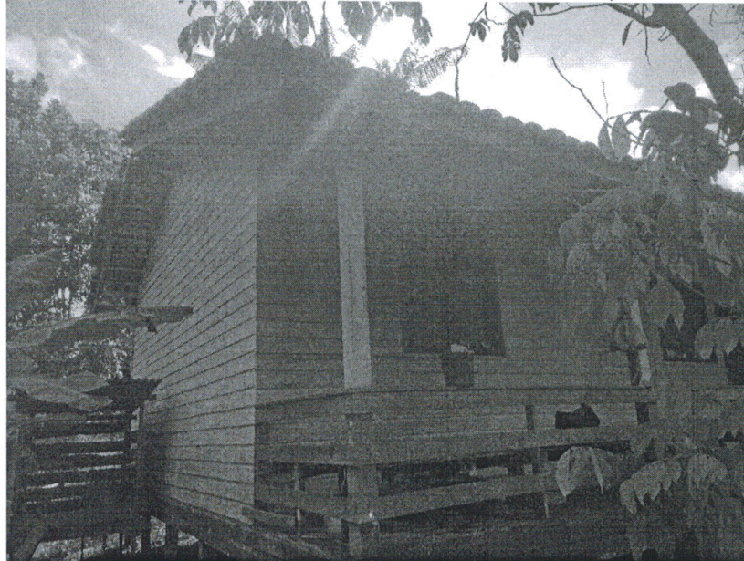
Imagem 21 – Ripas e caibros do telhado deterioradas, telhas caindo.
