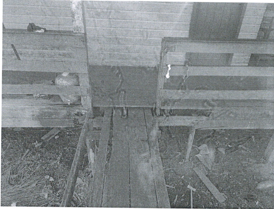
Imagem 07- Acesso ao pátio da escola.
